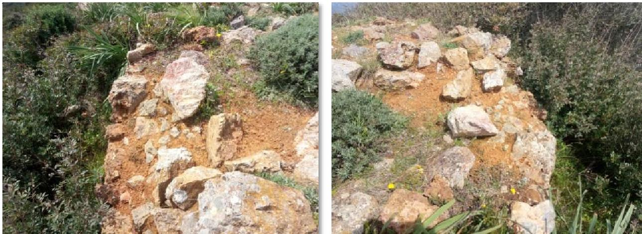
*Fig. 35. Alcuni resti della muratura. L'intercapedine muraria fra i due paramenti, quello interno e quello esterno, realizzati con pietrame selezionato, è riempita con malta di calce con affogati frammenti lapidei di varia dimensione*
